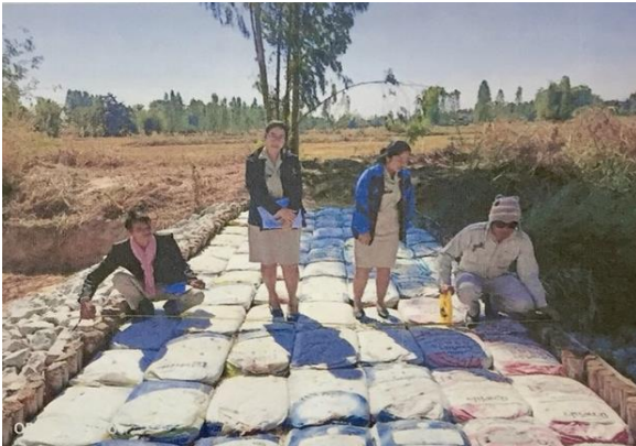
๖. ก่อสร้างฝายผสมผสานแบบกระสอบทรายลำห้วยคำตาแสน ม.๒
