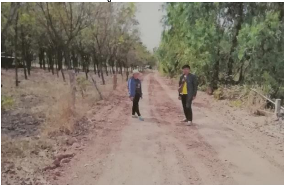
๑๕. ซ่อมแซมถนนลูกรังภายในตำบลสะอาดไชยศรีสายแยก คสล.เดิม-อ่างเก็บน้ำห้วยหินอ่อน ม.๗
