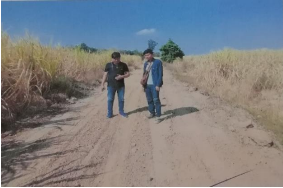
๑๖. ซ่อมแซมถนนลูกรังภายในตำบลสะอาดไชยศรีสายวัดอ่างคำ – ป่าช้าบ้านสายป่าแดง ม.๗
