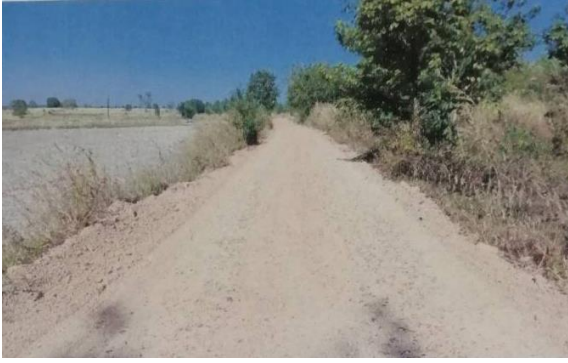
๒๔. ซ่อมแซมถนนลูกรังภายในตำบลสะอาดไชยศรีแยกบ้านโนนกอกโพธิ์อ่างคำ - นานายสัมฤทธิ์ ม.๒
